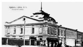
Здание Ирбитского драматического театра. Начало XX века
